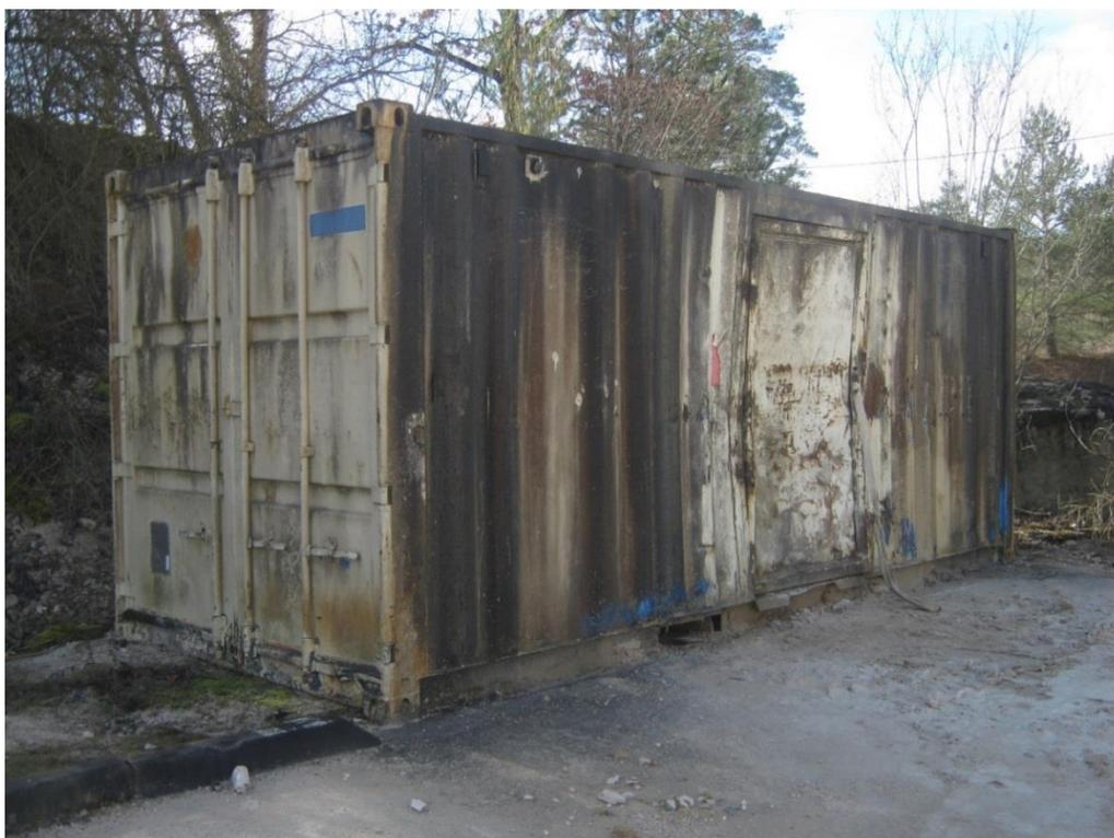
Figure 15 : Photographie du conteneur (en mauvais état extérieur) posé en dehors de l'aire étanche dans lequel sont entreposés les huiles et lubrifiants
